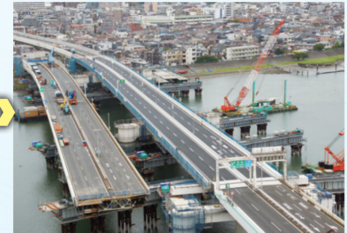
新設橋横取り完了
