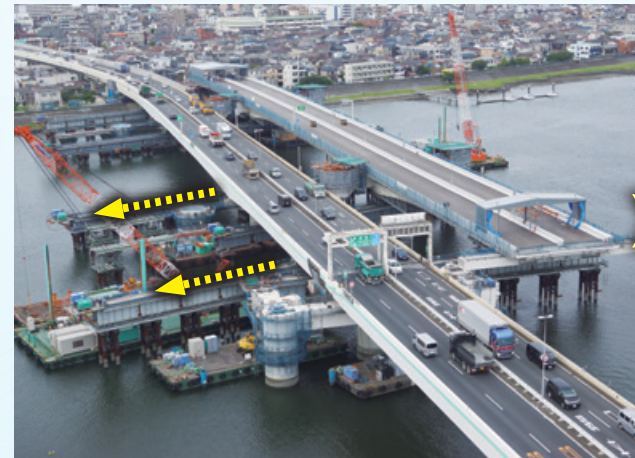
既設橋横取り前(左:既設橋 右:新設橋)
