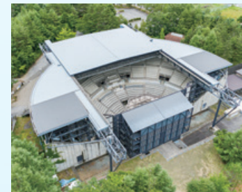
河口湖ステラシアター屋根開放時
