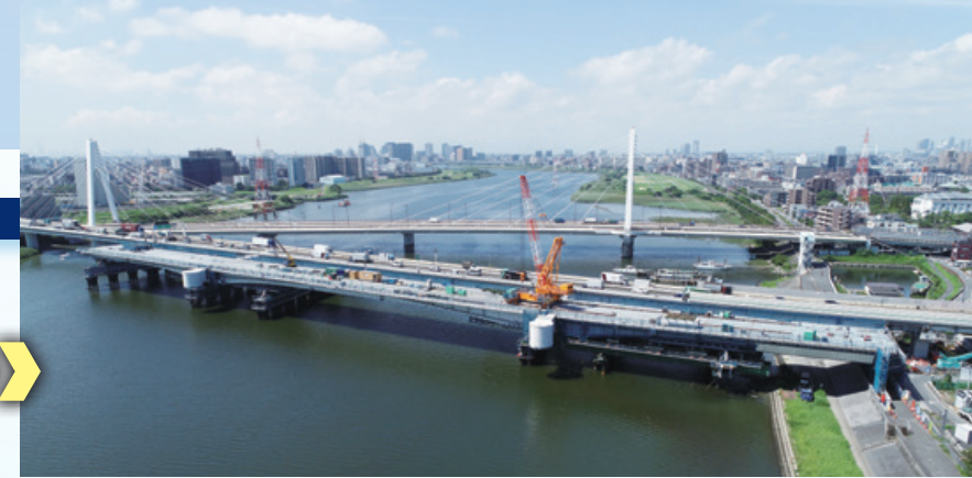
新設橋組み立て完了
