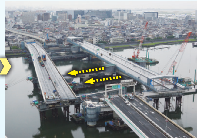
既設橋横取り完了
