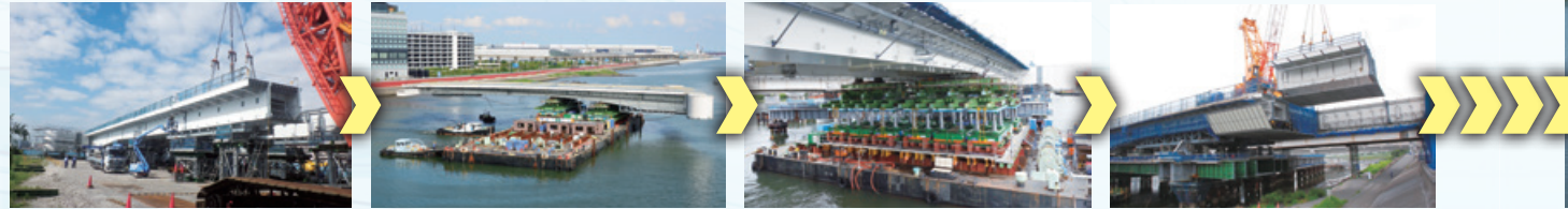
2径間を地上で組み立て
