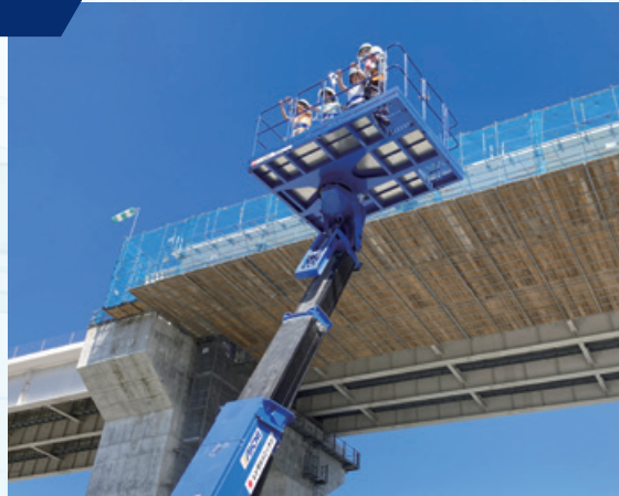
高所作業車で架設現場へ
