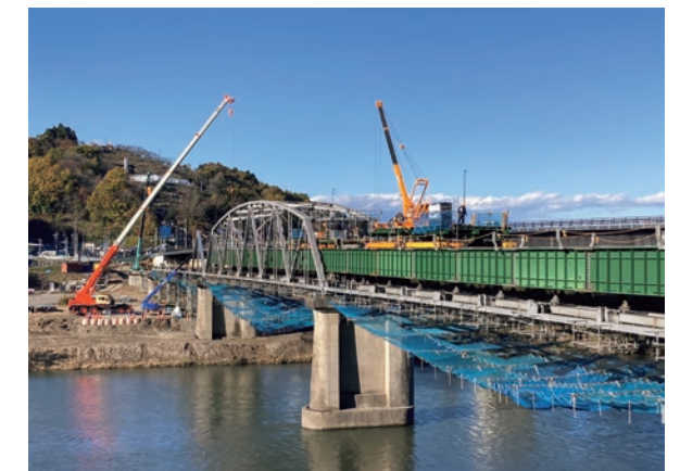
富士橋旧橋撤去工事 （発注者：山梨県）
