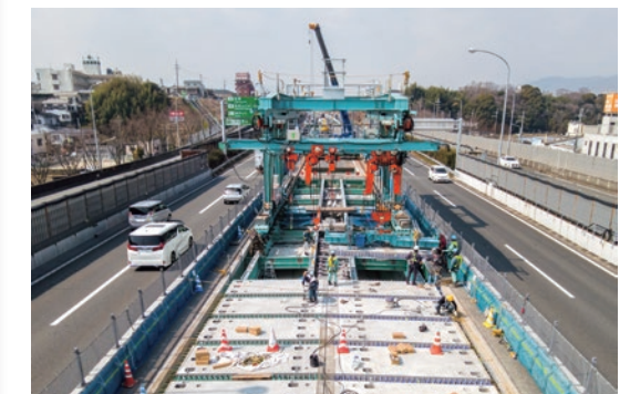
床版取替機による施工状況
