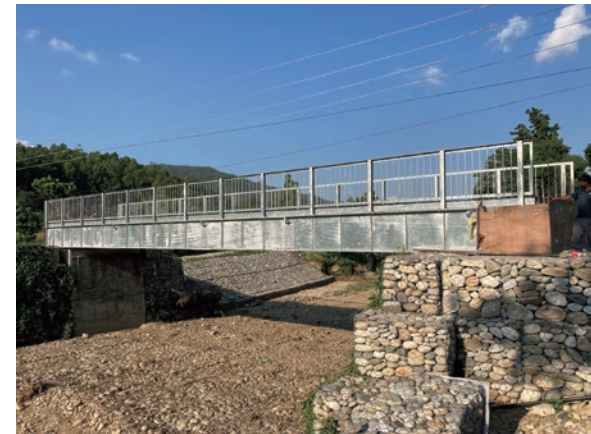
ネパール・簡易組立橋梁「PABRIS」
