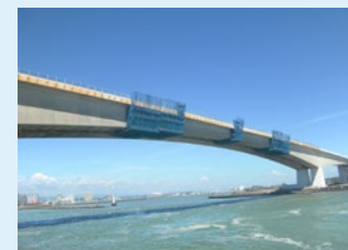
浜名大橋主桁補強工事
