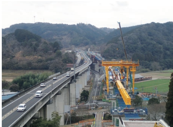
高速道路の暫定2車線区間の4車線化（香下大橋） （発注者：西日本高速道路株式会社）
