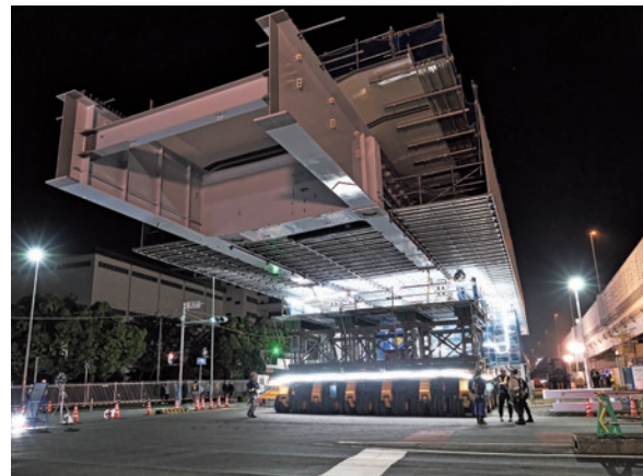
国道357号塩浜立体（交差点上夜間架設） （発注者：関東地方整備局）
