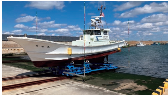
波崎漁港ラップ式上架施設（茨城県神栖市）
