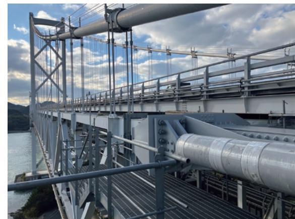
因島大橋耐震補強工事 （発注者：本州四国連絡高速道路株式会社）
