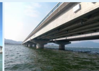
近江大橋主桁改築工事
