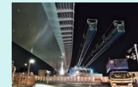
Cランプ第一橋送出し
