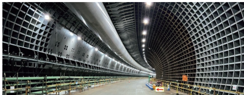
トンネルセグメント
