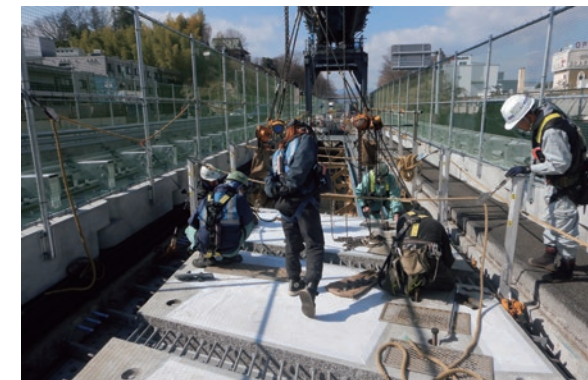
プレキャスト合成床版による床版取替工事
