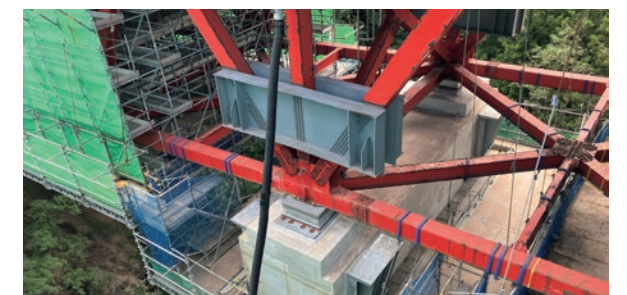
阿能川橋 支承交換完了
