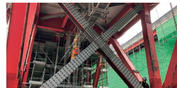
阿能川橋 対傾構補強
