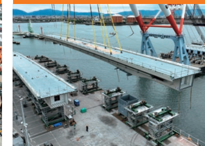
栈橋上での柱部材との連結
