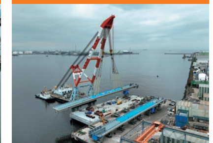
浜出し作業（台船への搭載）
