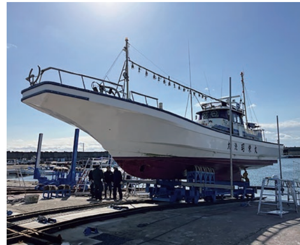
大洗漁港 船舶上架施設
