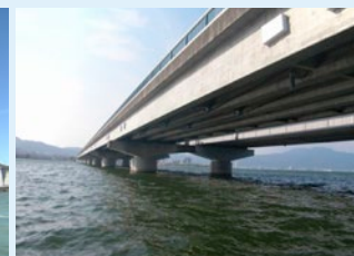
近江大橋主桁改築工事
