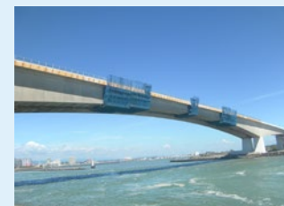
浜名大橋主桁補強工事
