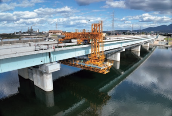
米子大橋での施工状況（発注者：中国地方整備局）
