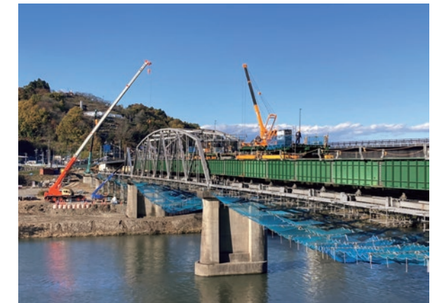
富士橋旧橋撤去工事 （発注者：山梨県）
