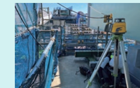
レーザーレベル設置状況
