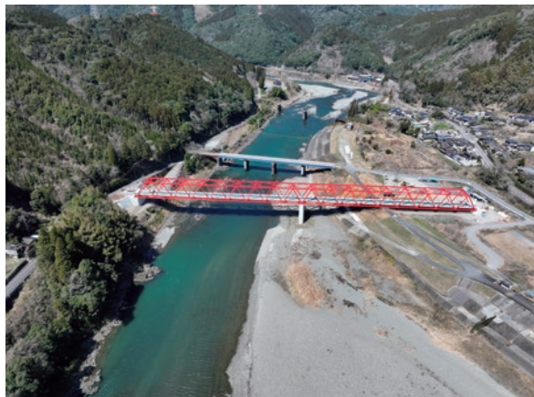
相良橋（球磨川流域橋梁災害復旧）上部工工事 （発注者：九州地方整備局）
