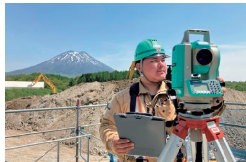
北海道新幹線ルベシバ川橋りょう（PCけた） （発注者：鉄道建設・運輸施設整備支援機構 北海道新幹線建設局）
