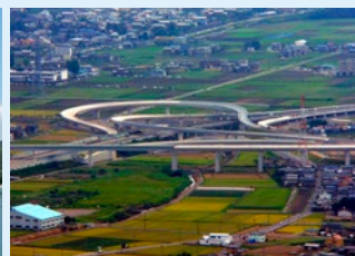
美濃関ジャンクション橋
