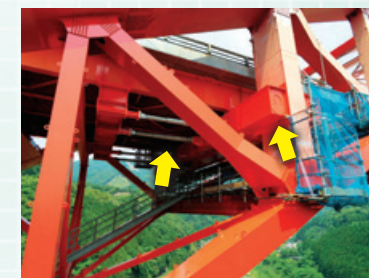
横梁を補強、粘性ダンパー設置
