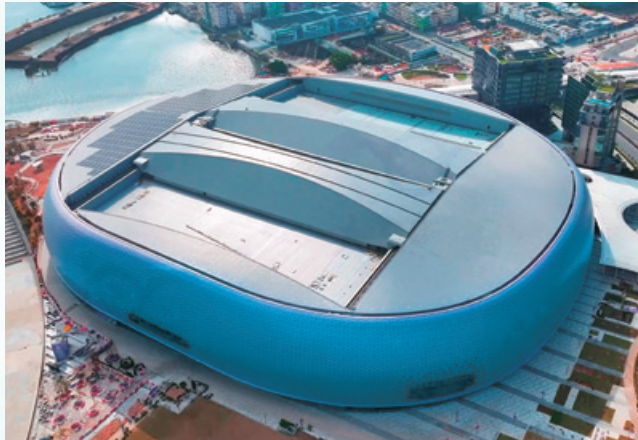
(右) 開閉屋根が閉じている状態
