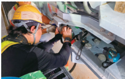
(上) 工事の様子 (左) 自動開閉屋根の調整作業中
