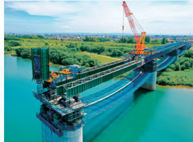
施工中の新濃尾大橋
