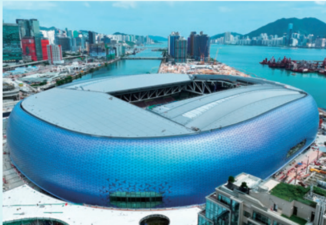
完成したカイトックススポーツパーク (左) 開閉屋根が開いている状態
