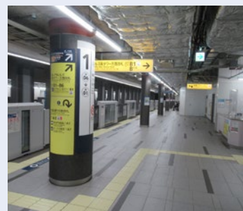
駅舎を支える厚肉鋼管柱
