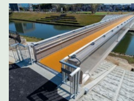
今之浦公園歩道橋
