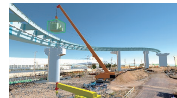
鋼橋施工シミュレーター
