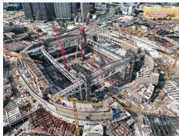
施工中の香港カイトックススポーツパーク メインスタジアム
