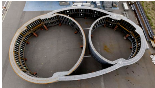
鋼製トンネルセグメントの仮組立
