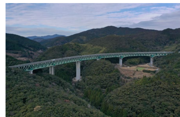
大豊IC～南国IC間耐震補強工事(曾我部川橋)
