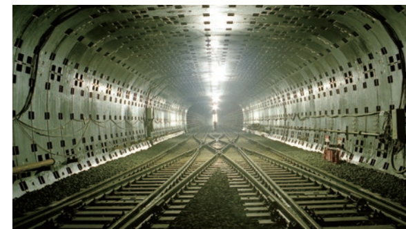
完成した地下鉄トンネル
