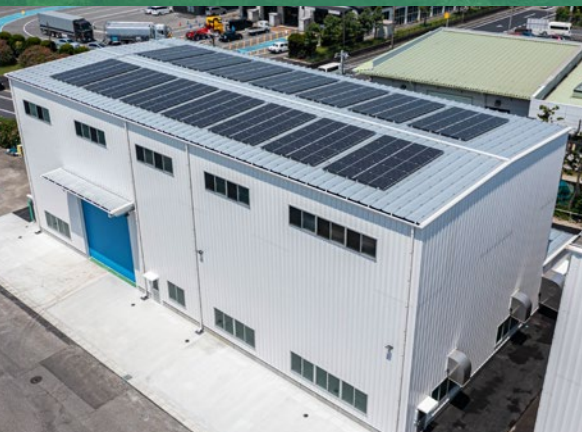
総合技術研究所 新第二実験棟に太陽光発電設備を設置
