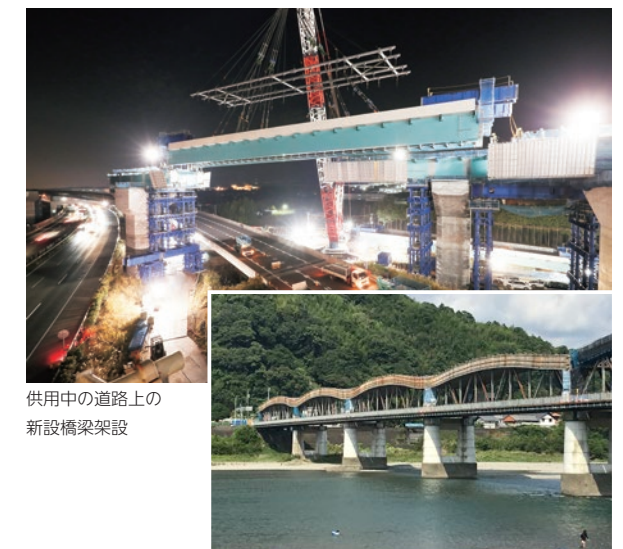
供用中の道路上の新設橋梁架設
