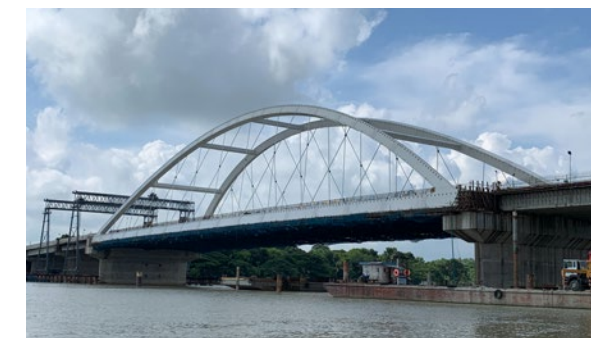
架設完了したカルナ橋
