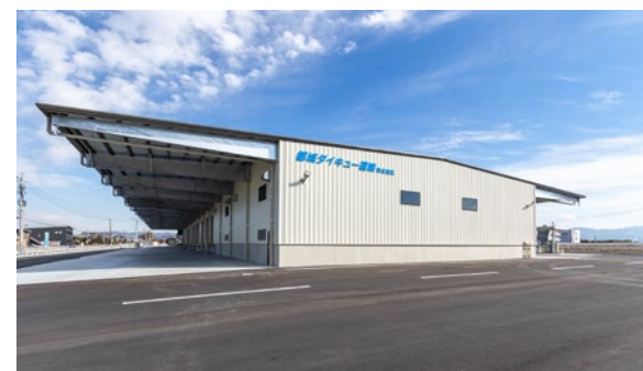
都城ダイキョー運輸株式会社 ターミナル新築工事
