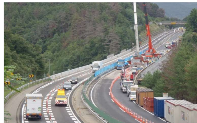
小仁熊橋床版取替
