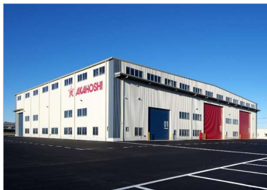
赤星工業株式会社富津工場工場棟
