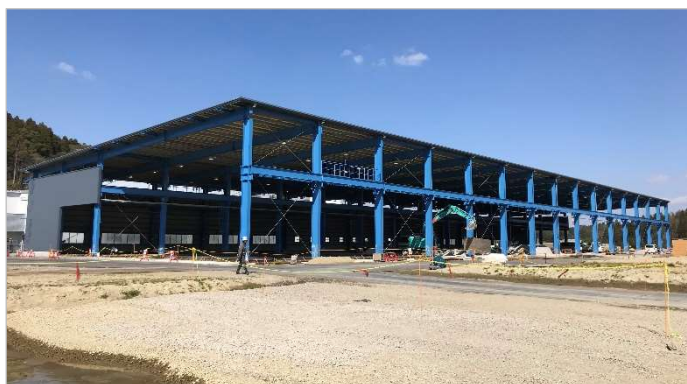
塗装・出荷ヤード棟
