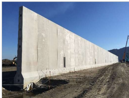
プレキャスト防潮堤
