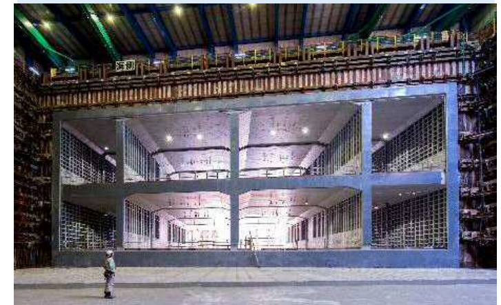
高速道路のトンネル
