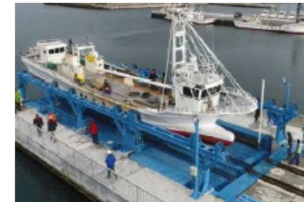
大洗漁港の船舶上架施設
