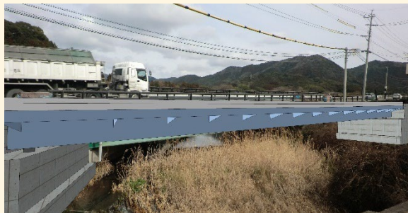
初めてグリーン鋼材を活用した新朝倉橋
