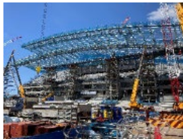
広島サッカースタジアムの建設
