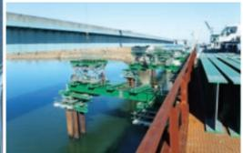
架設時の橋を支持する仮設備を設置します。すべての架設作業が完了した後、仮設備を解体します。
