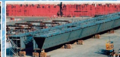
組み立てた個々のブロックを橋の完成形または部分的に仮組立することで形状や寸法に間違いがないかを検査して、現地での施工に不具合がないように確認を行います。仮組立には実際にブロックを組み立てる「実仮組立」とコンピュータによる3次元計測システムを用いた「シミュレーション仮組立」があります。
