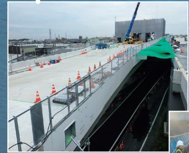
架設が完了した鋼桁の上に車両が通行できるよう床版をつくります。材料は主に鉄筋コンクリートですが、鋼板を用いて工場で作成する鋼床版もあります。
