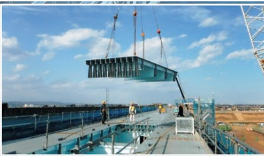
組み立てたブロックをクレーンなどを使って、設置する順番に吊り上げ、橋のかたちに架設していきます。
