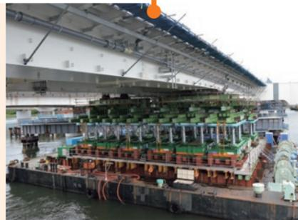
4 1径間はトラベラクレーンで架設
