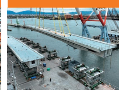
栈橋上での柱部材との連結
