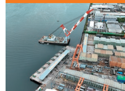
起重機船にて 地組立ヤードから栈橋へ横持ち
