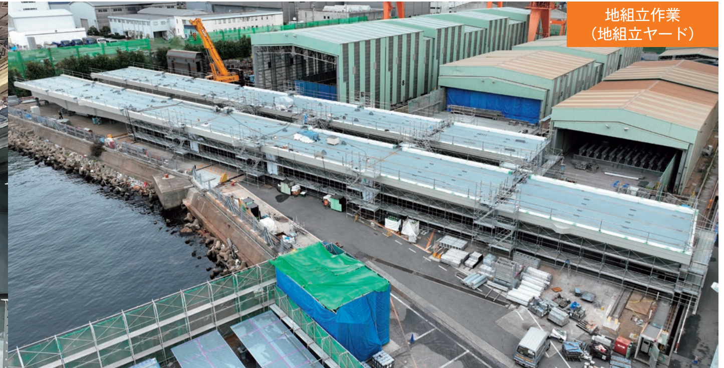
起重機船にて 地組立ヤードから栈橋へ横持ち
