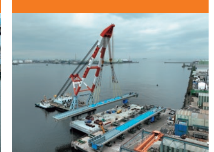
浜出し作業（台船への搭載）
