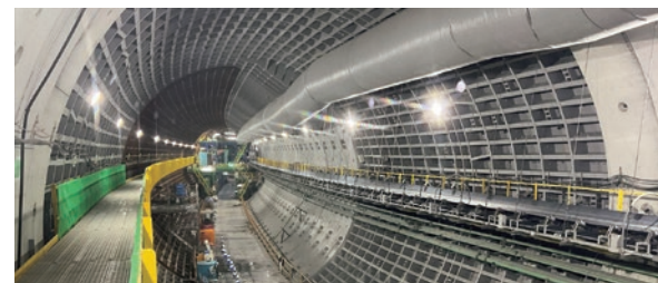
トンネルセグメント
