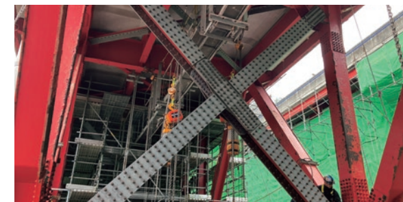
阿能川橋 対傾構補強
