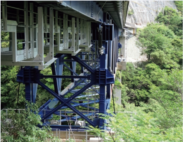
千切橋（せんじんばし） 座屈拘束ブレース設置状況
