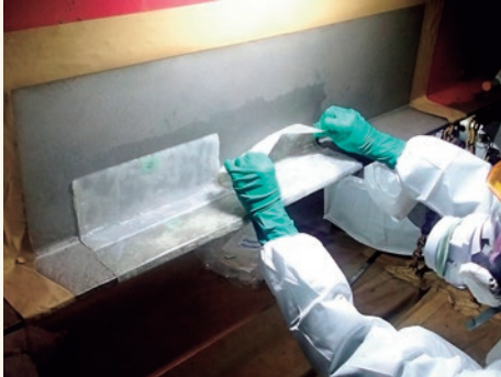
脱塩シートとシートの貼り付け状況
