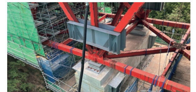
阿能川橋 支承交換完了
