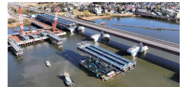
神宮橋 台船架設
