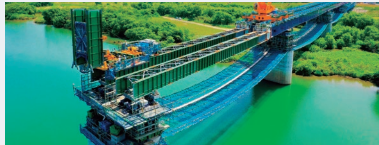
「後方回転・自走式手延機解体装置」で手延機解体中の新濃尾大橋
