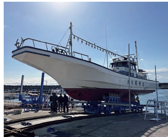
大洗漁港 船舶上架施設
