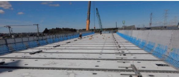
プレキャスト合成床版の架設完了状況
