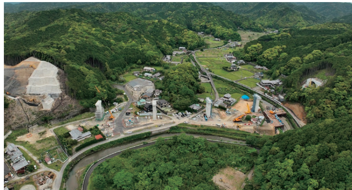
田並川橋（現場）
