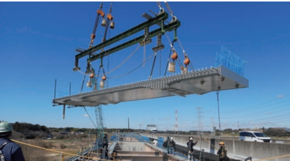
プレキャスト合成床版の架設
