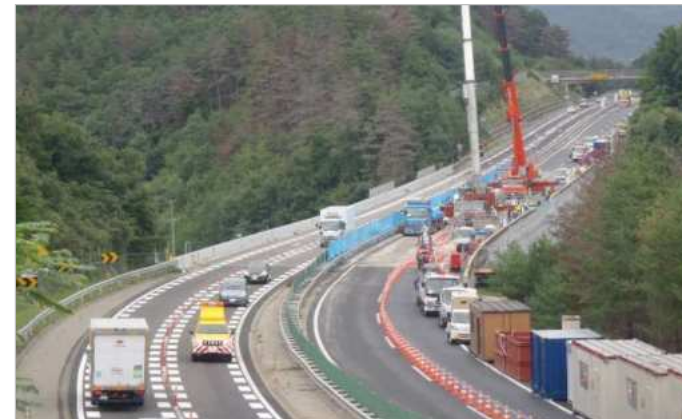
小仁熊橋床版取替
