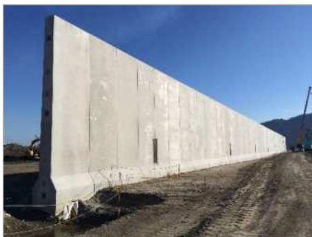
プレキャスト防潮堤
