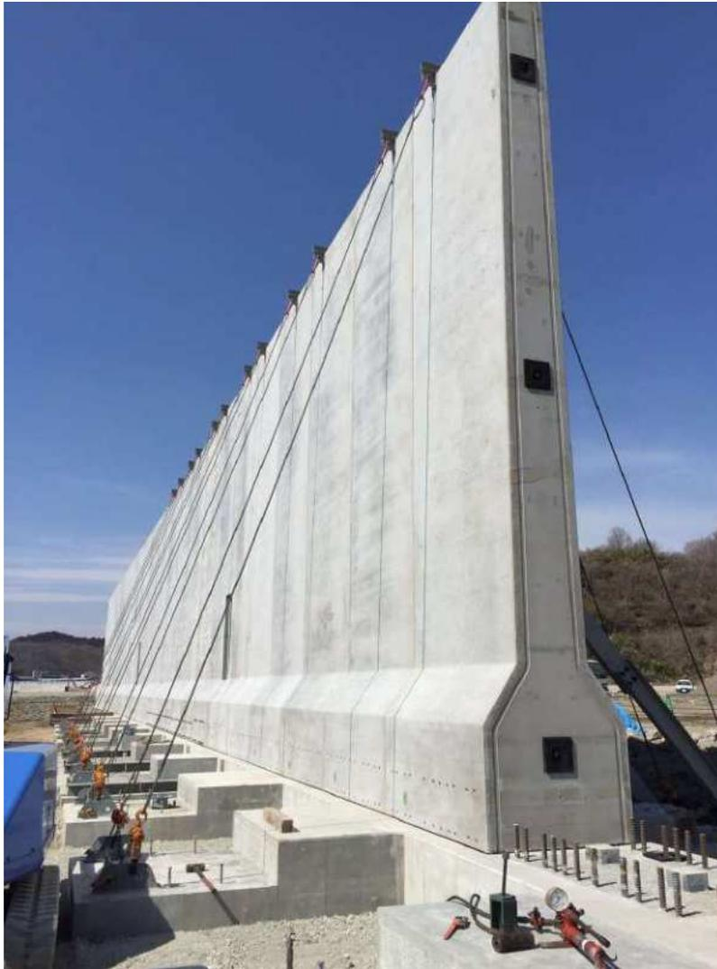
岩手県宮古港藤原地区では東日本大震災での津波の被害を受け、防潮堤の整備が進められています。この防潮堤は天端高さTP +10.4メートル、総延長約2.1キロメートルの規模で、巨大地震時の津波に対する防災・減災を図る計画です。
