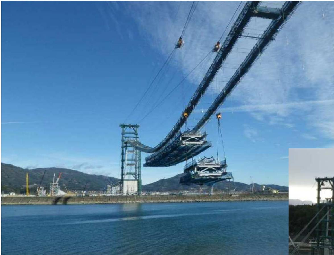
東日本大震災で甚大な津波被害を受けた陸前高田市街を嵩上げ復興する被災市街地復興整備事業の1つで、気仙沼側の山を切り崩し、気仙川の対岸にある嵩上げ区間に、直接ベルトコンベヤーで土砂を運搬するための吊橋です。
