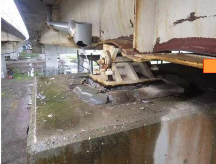
地震により破損した固定沓
