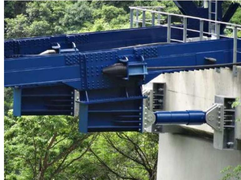
パワーダンパーは、橋梁上部一下部構造間に設置する耐震性能に優れた粘性型ダンパーです。地震時には内部の粘性オイルにより振動エネルギーを吸収し、上部構造の揺れを抑制します。
