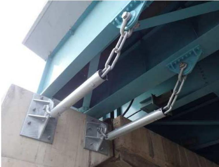
緩衝機能付き落橋防止チェーンは、橋梁における落橋防止構造の一つで、地震時に橋梁上部工が落下することを確実に防ぐとともに、地震時の衝撃的な荷重を緩和する機能を有します。
