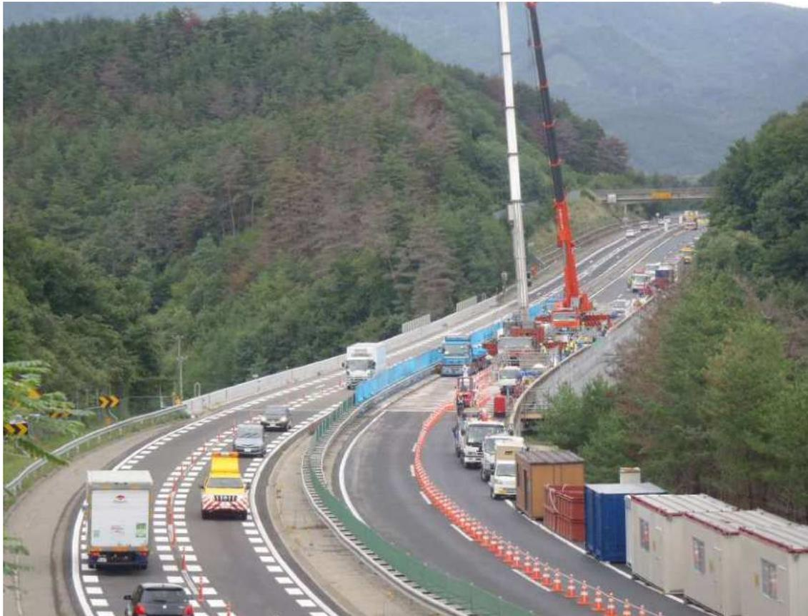
本工事は、開通から23年経過した長野自動車道の安曇野IC～麻績IC間に位置する小仁熊橋の床版を取り替える工事で、2017年12月に完了しました。
