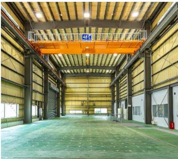
新第二実験棟内部
