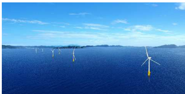
長崎県五島市で日本初の浮体式洋上風力発電設備を実用化 (戸田建設(株)HPより引用)
