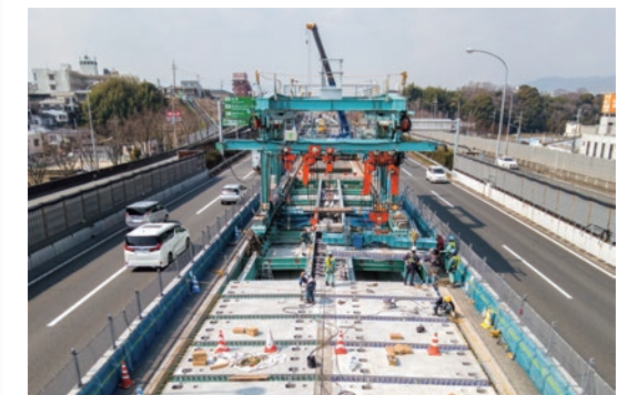
床版取替機による施工状況
