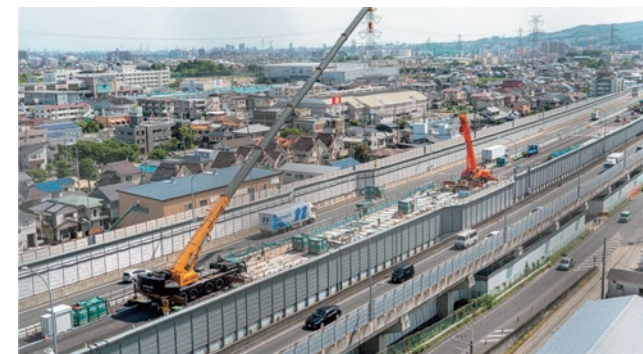
220トンクレーンを2台配置して既設桁撤去および新設桁を架設
