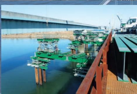
架設時の橋を支持する仮設備を設置します。すべての架設作業が完了した後、仮設備を解体します。
