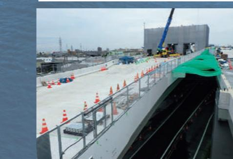
架設が完了した鋼桁の上に車両が通行できるよう床版をつくります。材料は主に鉄筋コンクリートですが、鋼板を用いて工場で製作する鋼床版もあります。
