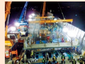
夜間全面通行止めによる施工状況
