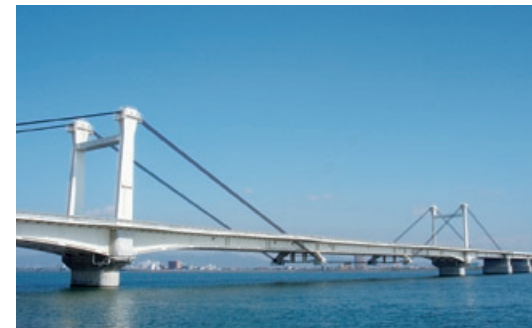
ケーブルイグレット部分
