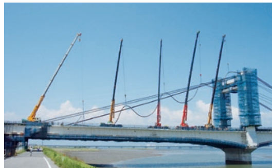
ケーブル取付状況
