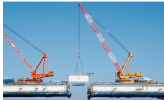
中央径間の閉合状況
