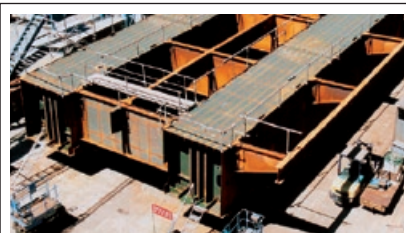
仮組立ヤードにおける仮組中の橋梁
