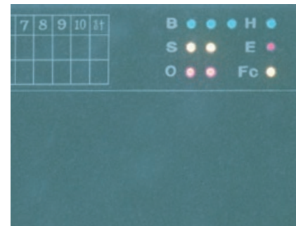
工事完了後の点灯試験
