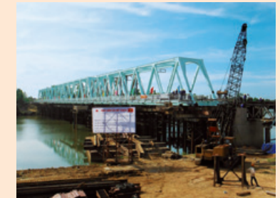
施工状況写真
