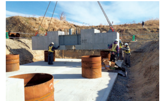
フーチング据付
