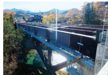
▲【写真④】桁架設が完了
