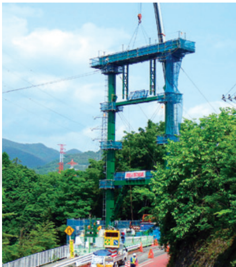
▲【写真②】鉄塔の架設
