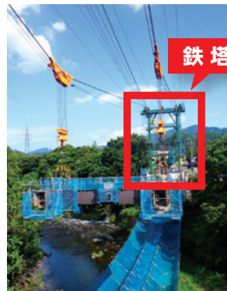
▲【写真③】ケーブルクレーンを使用したアーチリブ架設(ケーブルクレーン斜吊工法)
